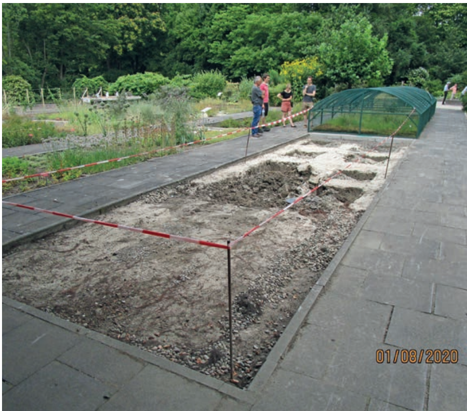
Abb. 9: Baustelle des geplanten Kalkflachmoorbeetes
